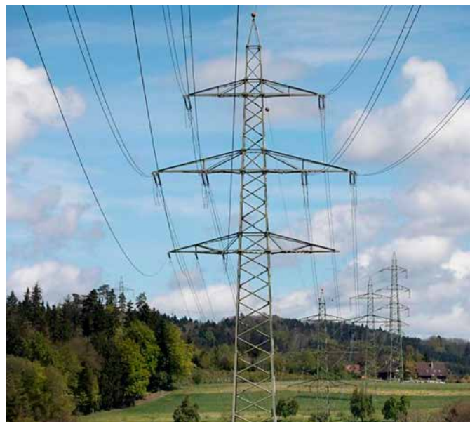
Ligne électrique de haute tension
