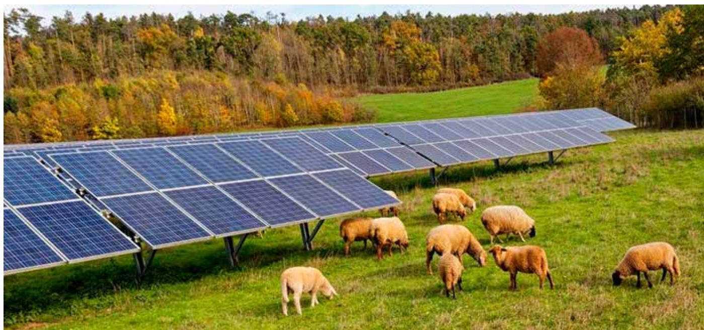
Ferme solaire permettant l'élevage d'ovins et la production d'électricité
